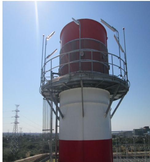
GT#12 #11 CEMS Calibration, Terminal Tighten, filter အစားထိုးခြင်း, sensor သန့်ရှင်းရေး
